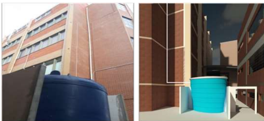
Sistema de coleta e utilização de Água Pluvial
